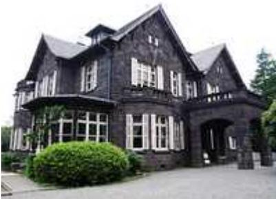
ジョサイア・コンドル最晩年の作で、大正 6 年 5 月に竣工しました。躯体は煉瓦造、外壁は真鶴産の新小松石（安山岩）の野面積で覆われ、屋根は天然ストレート葺き、地上 2 階・地下 1 階となっています。
